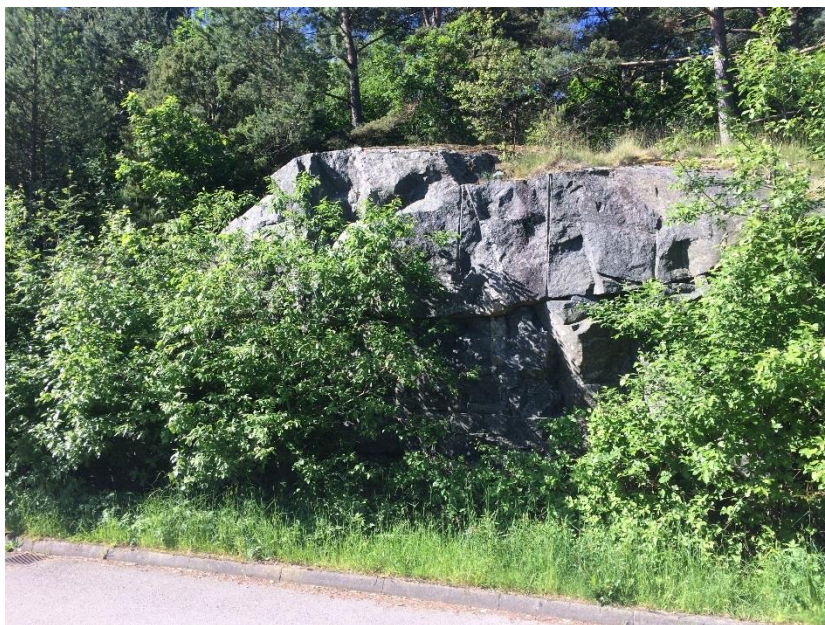
Foto 3. Den utmed Valebergsvägen högsta bergskärningen ca 2-3 m hög
